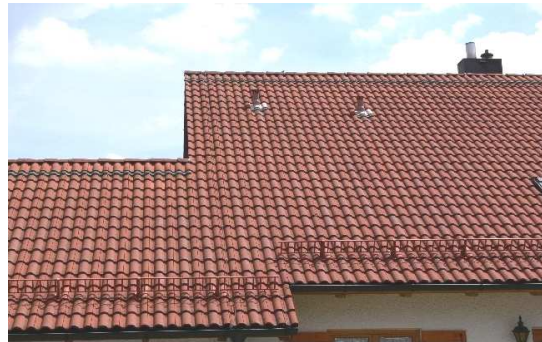
01.06.2009: foto van de noordzijde. Beoordeling: op sommige plekken nog sterk vastgezette verontreiniging, onder de dakplaten geen witte strepen van zwavel. Nok nog steeds vervuild met korstmos en vervuild door luchtverontreiniging. Montage van nokplaten was een betere keuze geweest.
